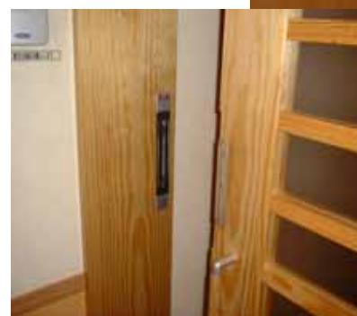
開扉状態 枠側
